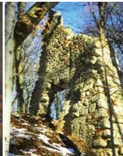
Mauerreste Schloss Helfenberg
